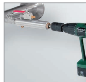
Сверление под давлением с помощью специального приспособления
