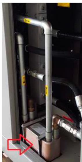
Рисунок-1 Пример теплообменника, установленного на компрессоре
