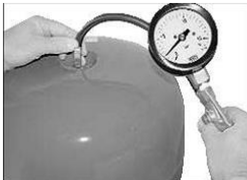
Рис. 6 Контроль давления в мембранном баке
